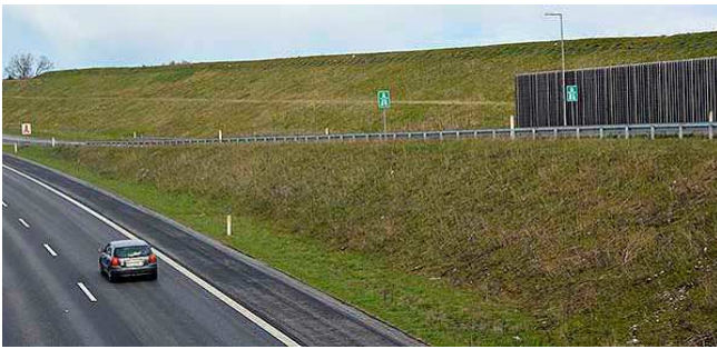
Meget høje, terrasserede støjvolde, kombineret med støjskærme ved Køge Bugt motorvejen. Eget foto, april 2016.
